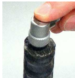
鉄筋ガス切断面
