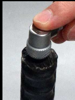
鉄筋ガス切断部
