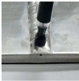
突合せ溶接部
